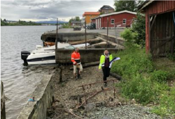
Figur 4 Bilde av området som trenger ny vinkelmur
